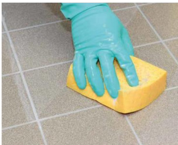
6 ... а возникший в результате этого раствор собрать с поверхности вискозной губкой. Воду для ополаскивания губки время от времени менять.
