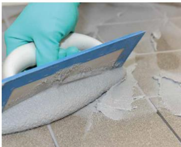
4 Перемешанную затирочную смесь нанести на поверхность облицовки и равномерно распределить с помощью специального шпателя для эпоксидных смесей, заполняя старательно все пространства между плитками. Избыток материала с поверхности облицовки собрать шпателем по диагонали к сетке швов.
