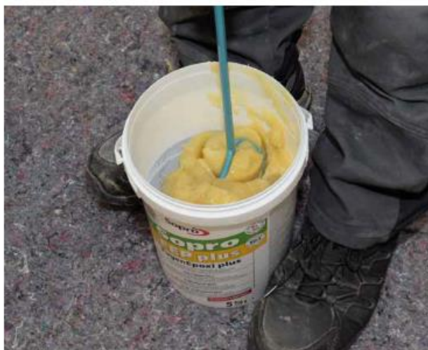
2 ... мешать около 3 минут с помощью низкоскоростного механического смесителя (не более 400 оборотов/мин.) до получения однородной массы без пузырьков воздуха.
