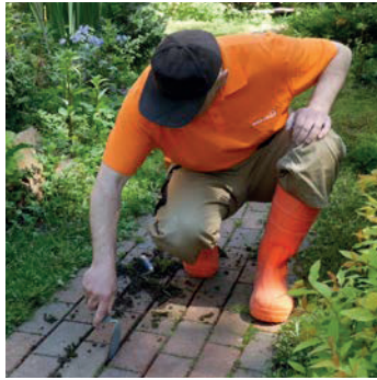
Проростання бур'янів через модифікований пісок FUS
